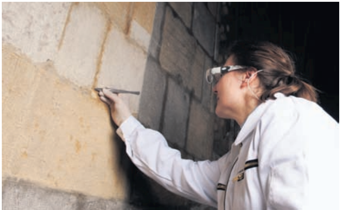
L'équipe pluridisciplinaire a appliqué différentes techniques de nettoyage dans le cadre de la restauration de la Collégiale.
