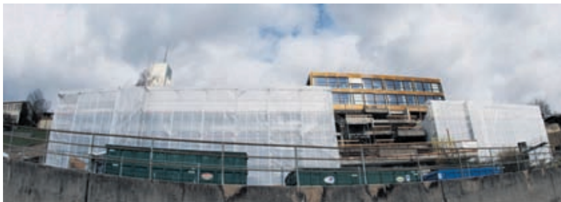
Le collège du Crêt-du-Chêne à La Coudre subit d'importants travaux d'assainissement et de rénovation.
