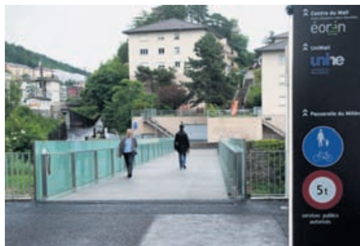
La passerelle du Millénaire est ouverte aux piétons ainsi qu'aux cyclistes.
