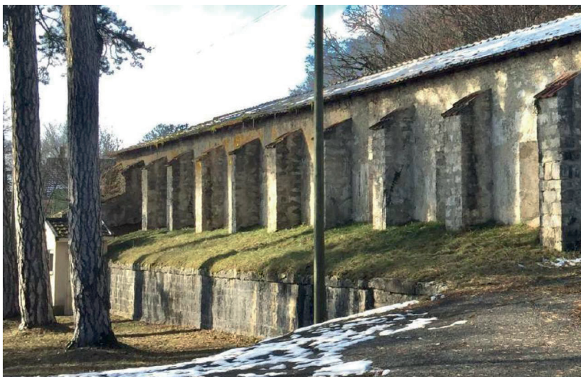
6 - Bâtiment des anciens filtres
