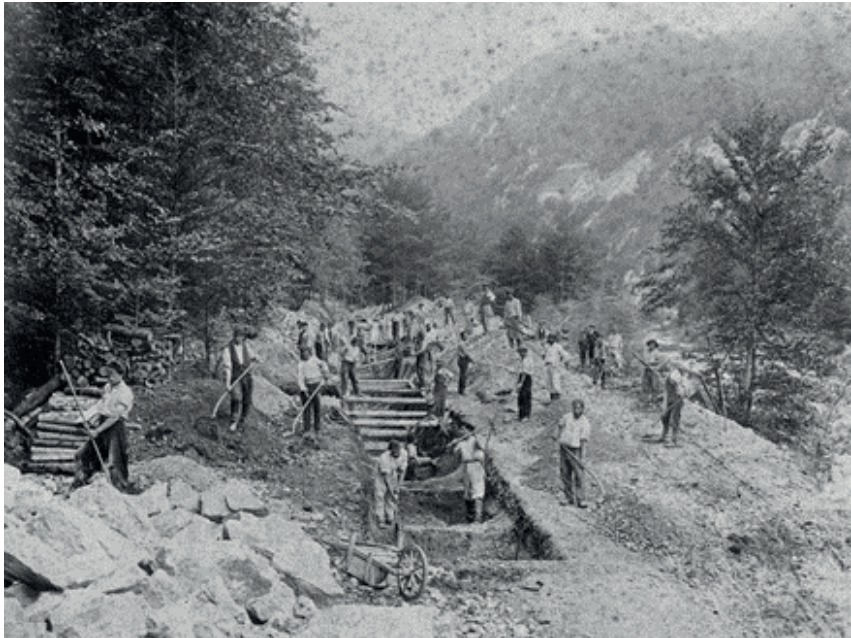
1 - Construction de l'aqueduc pour l'acheminement l'eau des sources de l'Areuse sur le Littoral et Neuchâtel en 1886 (Source : Musée d'art et d'histoire, Neuchâtel)
