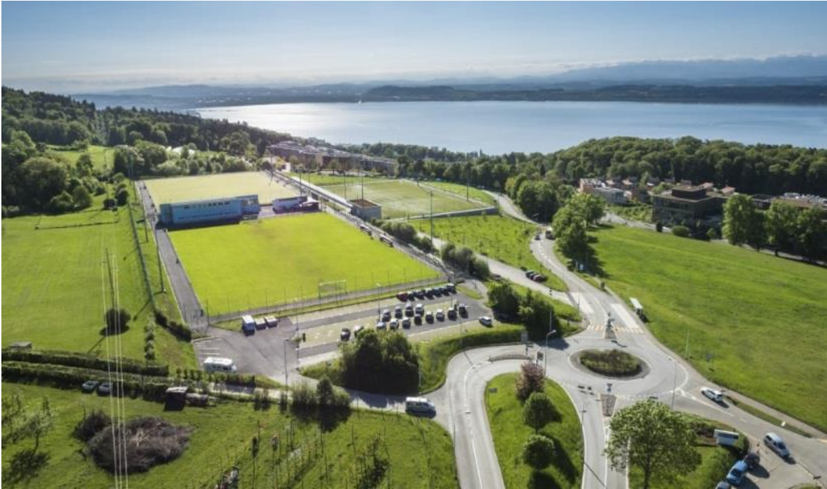
Vue aérienne des 3 terrains (terrain concerné à droite sur l'image)
