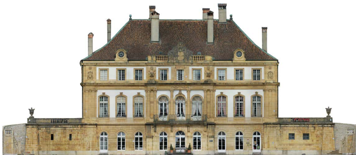
Figure 1 Vue de la façade du bâtiment principal depuis le Sud
