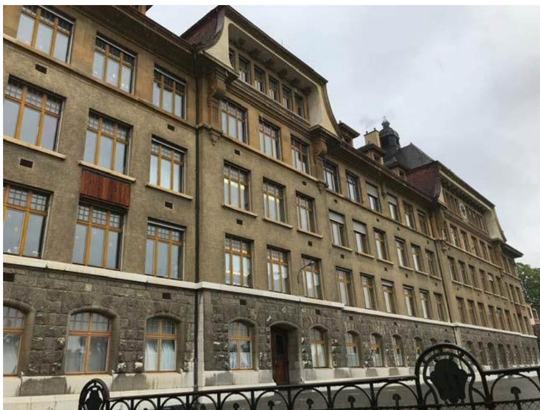
Figure 8 : Façade Sud du collège des Parcs
