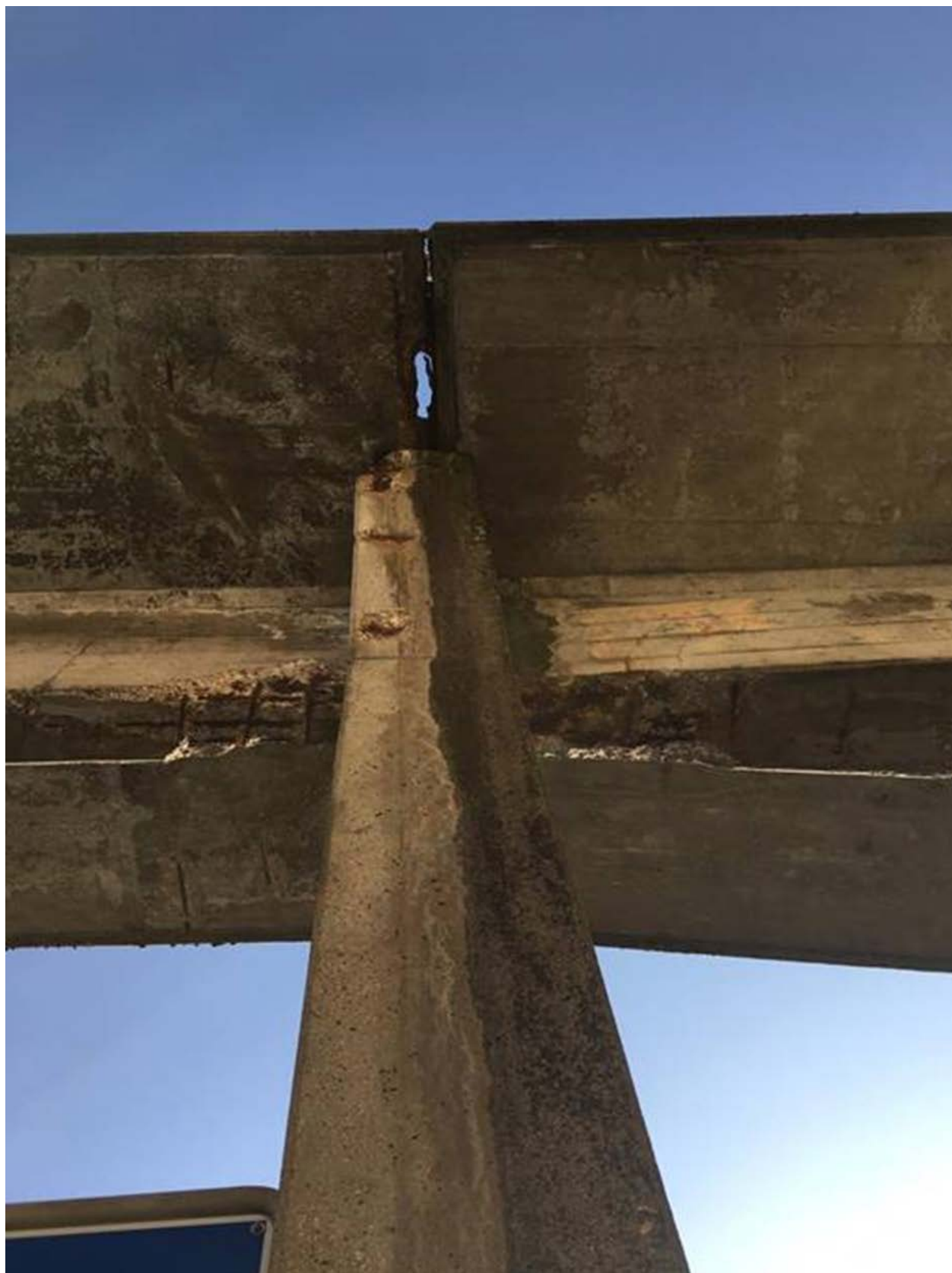
Etat de la passerelle 30 mars 2019
