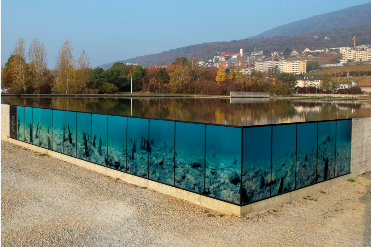
Figure 1 – Les panneaux solaires imprimés du projet «emersion» présentant le site palafittique de Bevaix sur le bassin du Laténium
