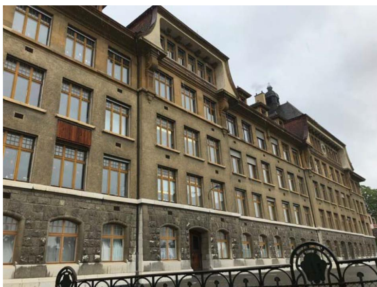
Figure 8 : Façade Sud du collège des Parcs
