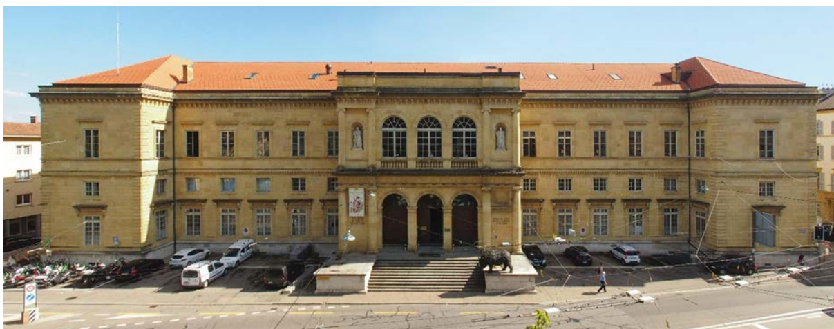
Collège latin, façade nord (photo BPUN)
