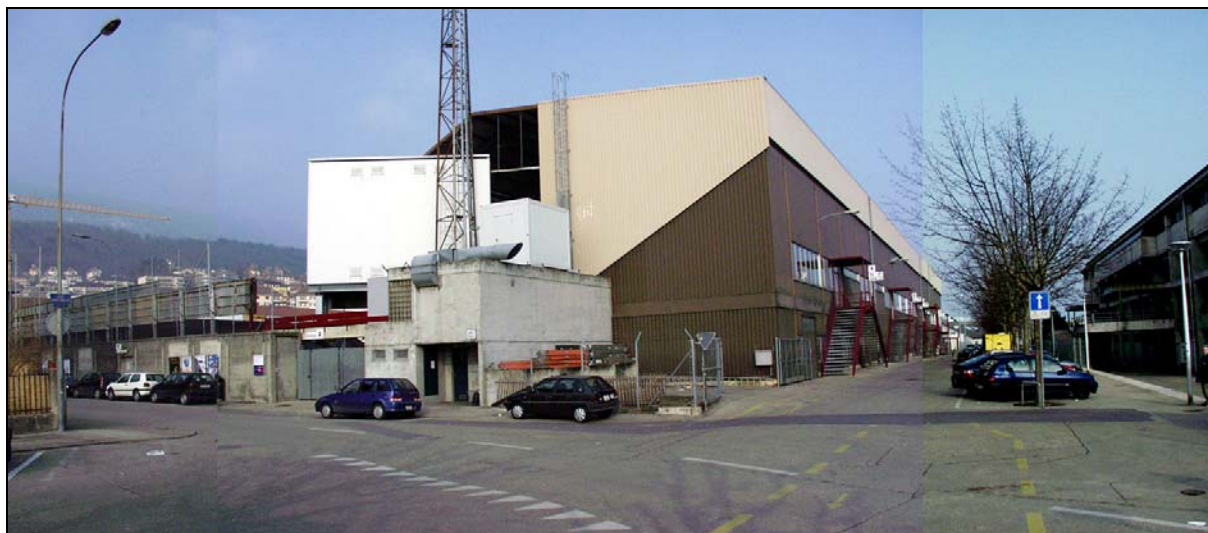
Le stade actuel : une infrastructure en sursis
