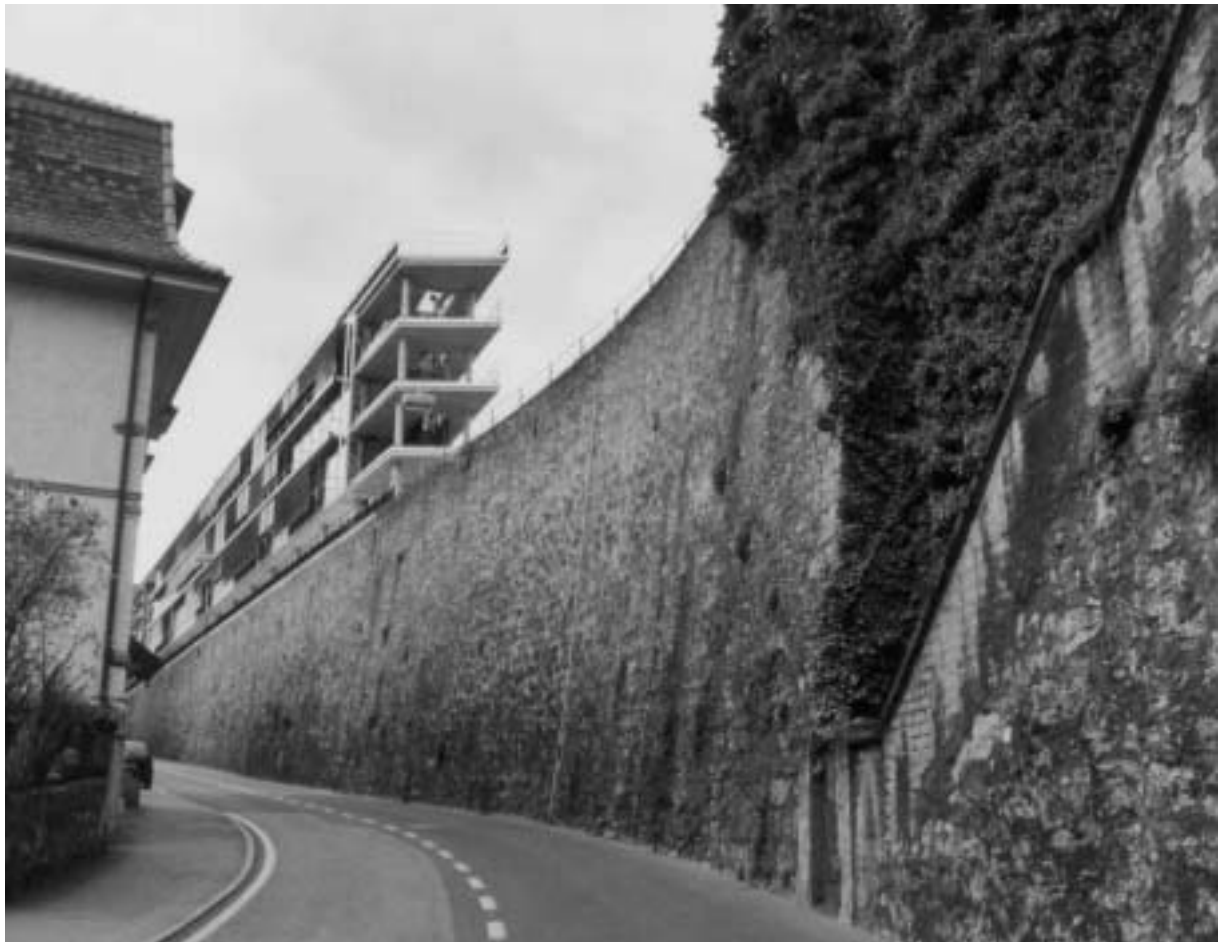
Figure 2 : Vue depuis le bas de la rue Crêt-Taconnet en direction ouest
