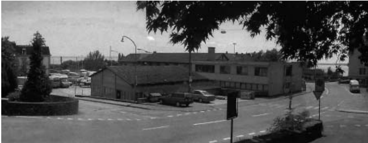
Figure 1 : Vue du site depuis le nord
