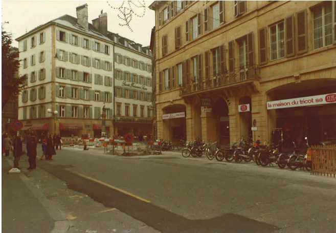
Rue de l'Hôpital, avant travaux
