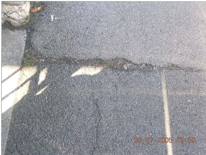
Rue du Clos-de-Serrières
