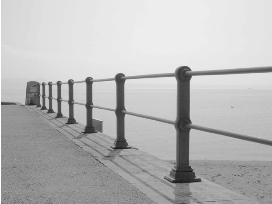
Illustration 2 : Photo de la barrière existante
