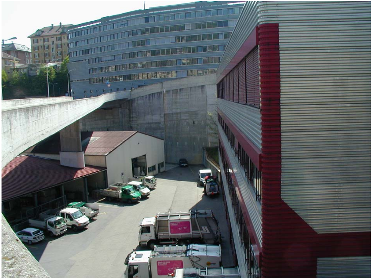
Figure 4 : accès direct et proximité entre les locaux de la Voirie et le bâtiment de Petitpierre et Grisel
