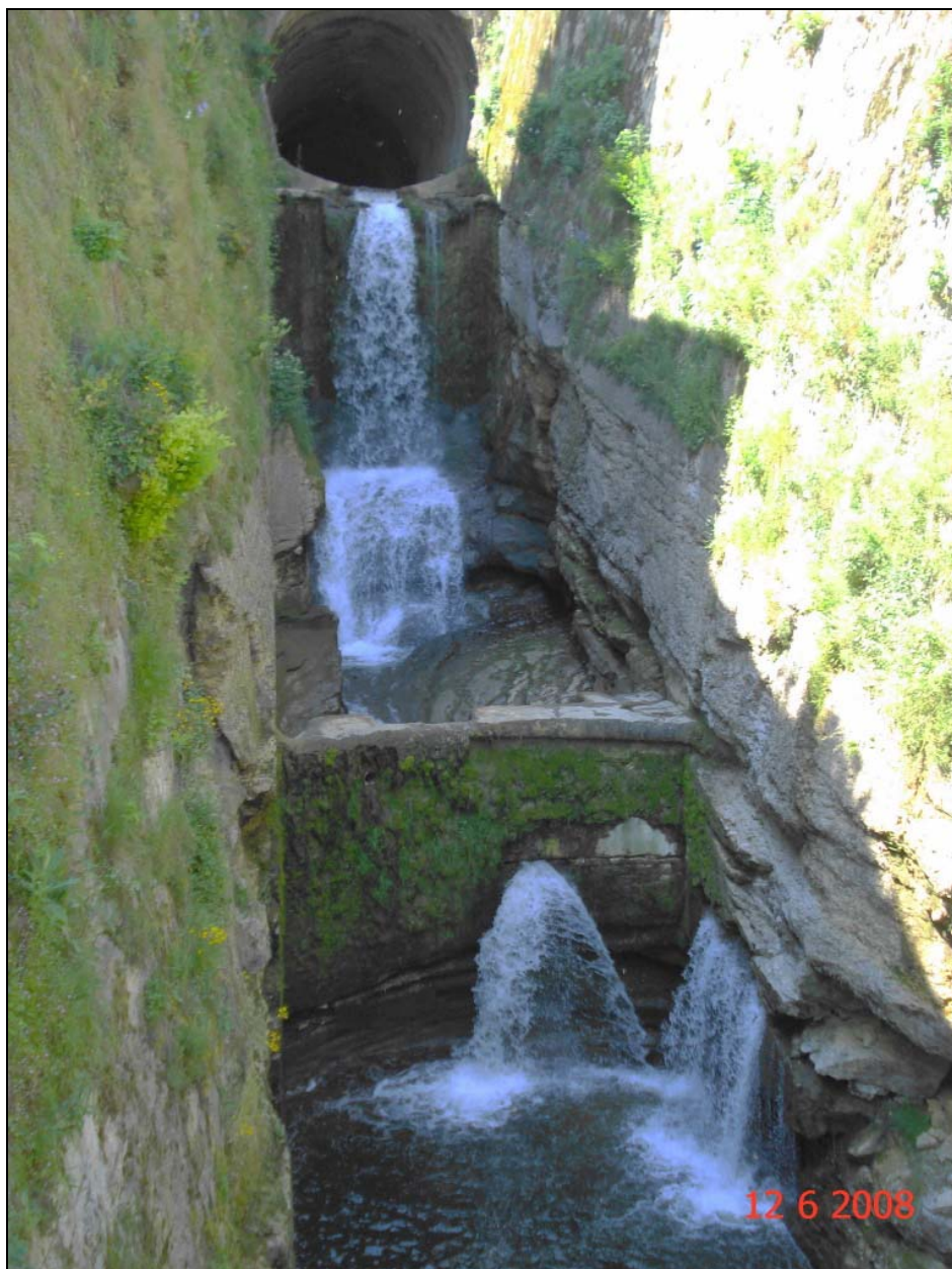
Sortie de la galerie, zone affectée (bas niveau d'eau – 100 litres/seconde)
