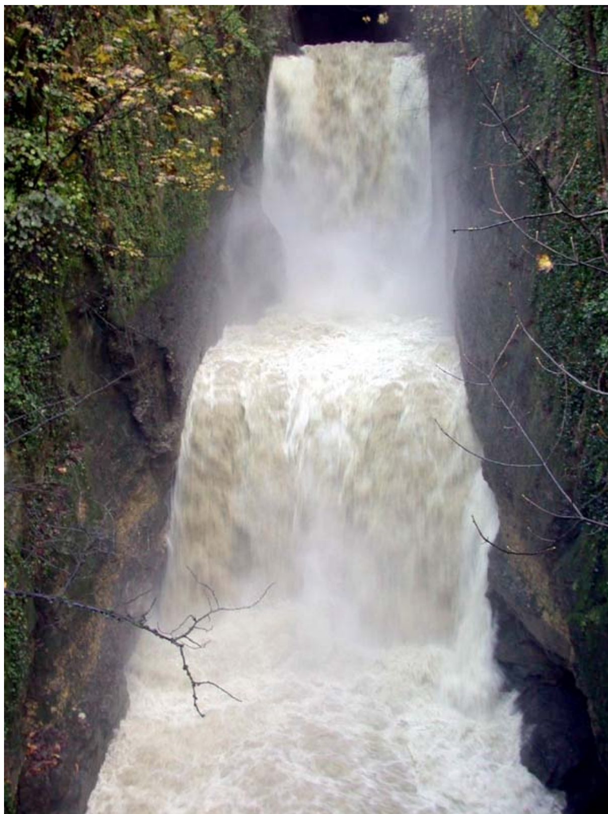
Sortie de la galerie, zone affectée (Seyon en crue 10'000 litres/seconde)
