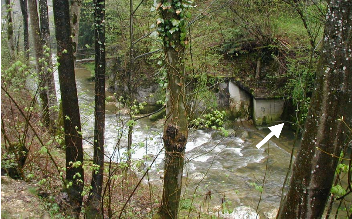
photo 2 : début de l'aqueduc (prise d'eau)
