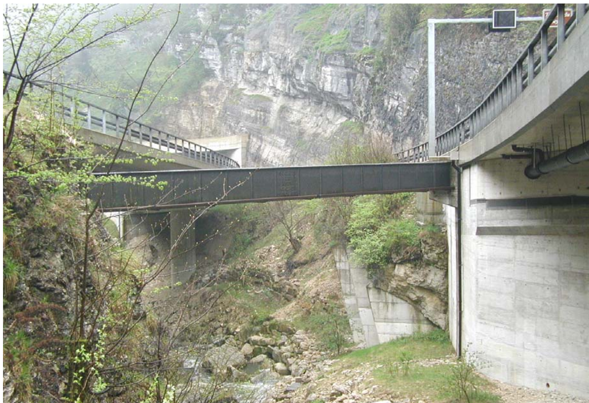
photo 1 : passage en pont-tube métallique
