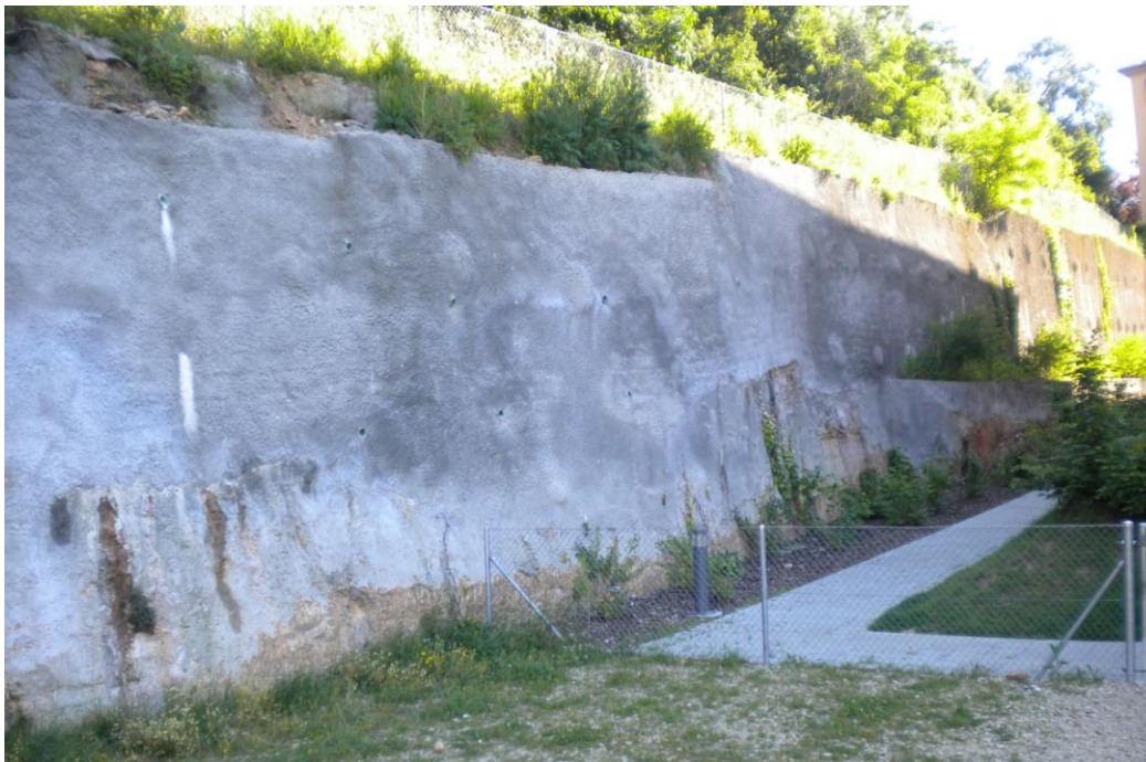
Exemple de paroi gunitée
