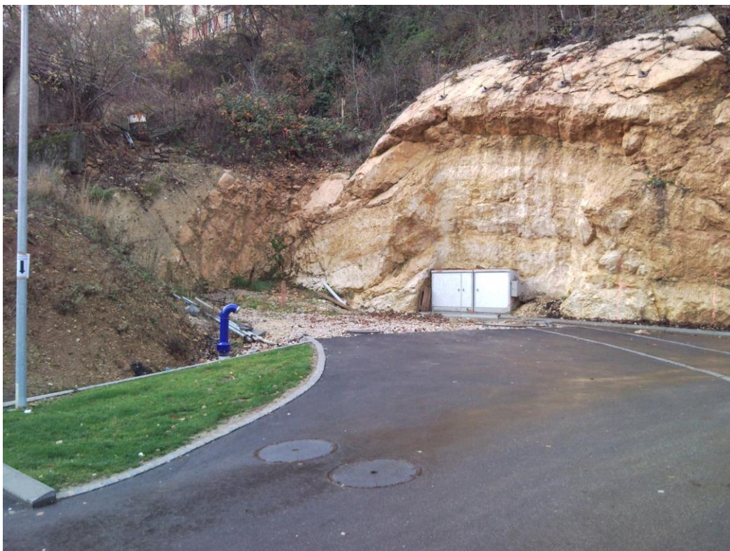
Amorce de la desserte future depuis le nouvel accès est, présence massive de rocher
