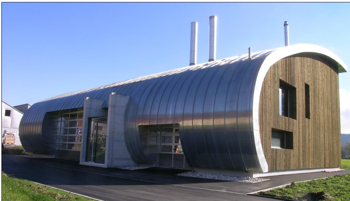
Centre forestier, Les Ponts-de-Martel
