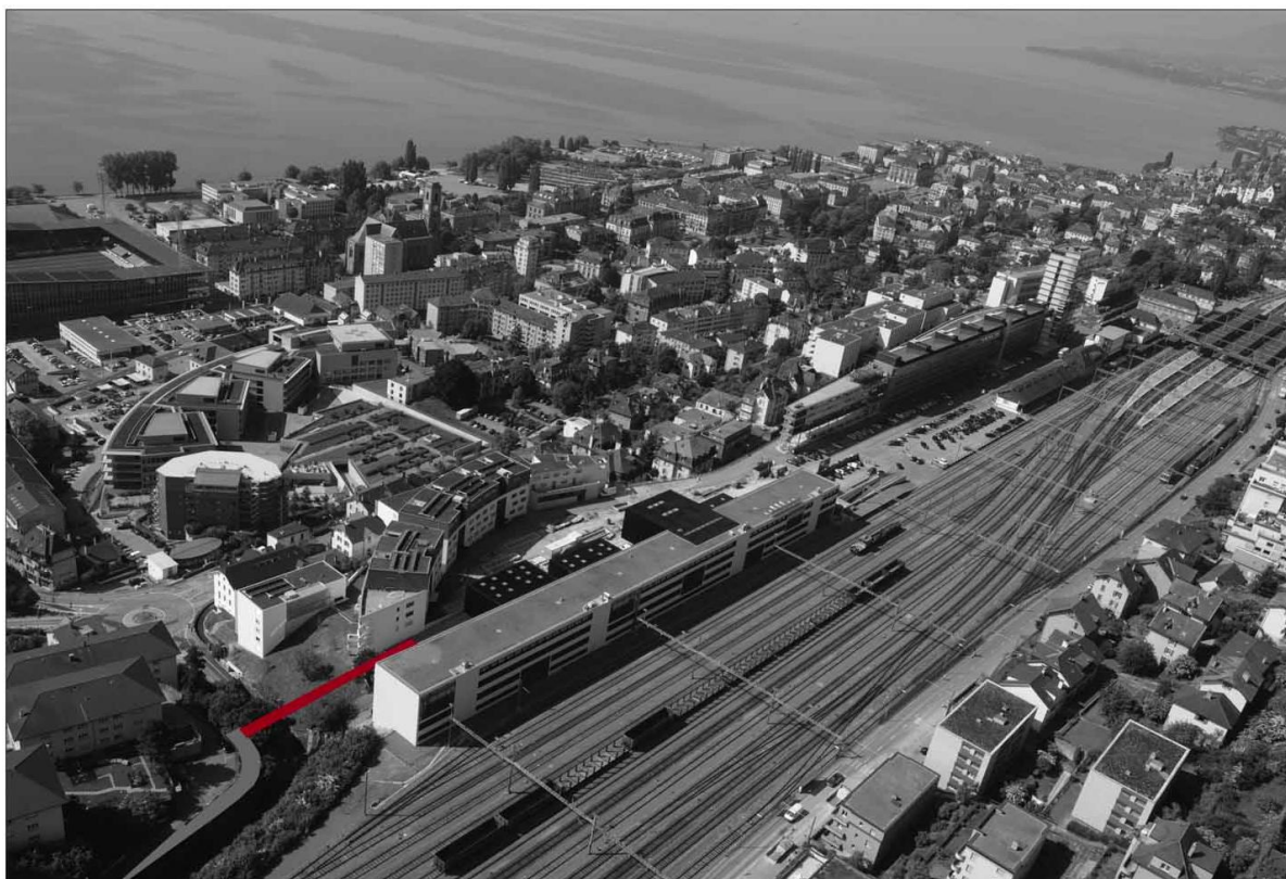
Figure 19: passerelle dans le site
