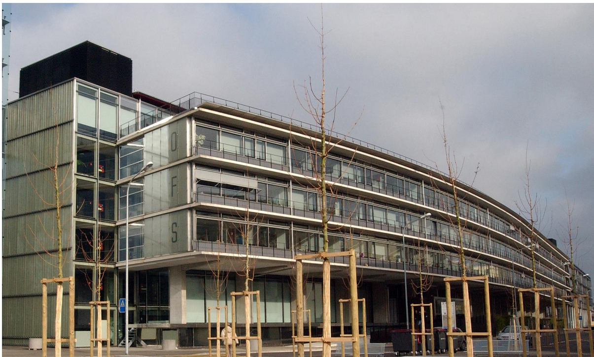
Figure 5 : bâtiment de l'OFS
