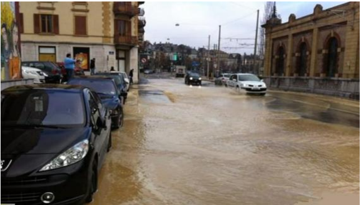
Fuites d'eau à la rue de l'Evole et au quai Philippe-Godet
