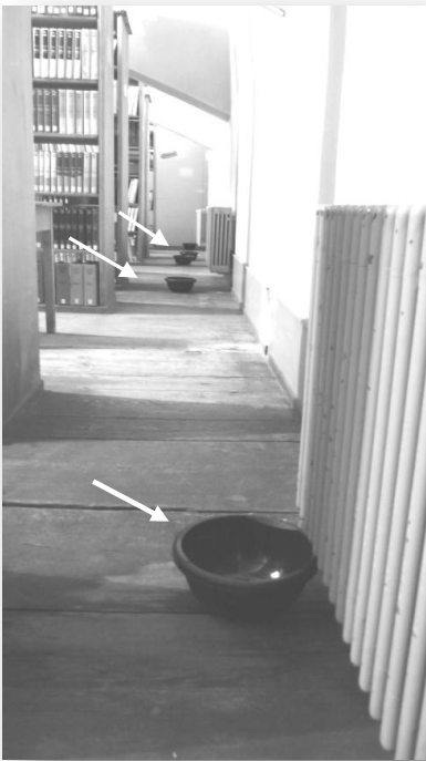
Figure 7. Récipients destinés à limiter les inondations dans les combles
