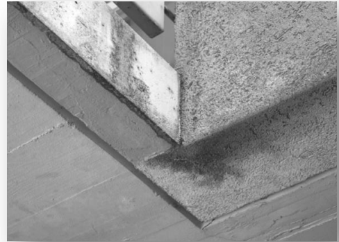
Figure 7. Illustration des dégâts. Plafond et dessous de balcons en béton
