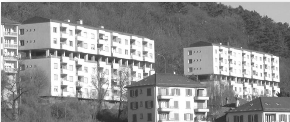
Figure 5. Unités d'habitation rue de l'Orée 58 à 62 et 64 à 68
