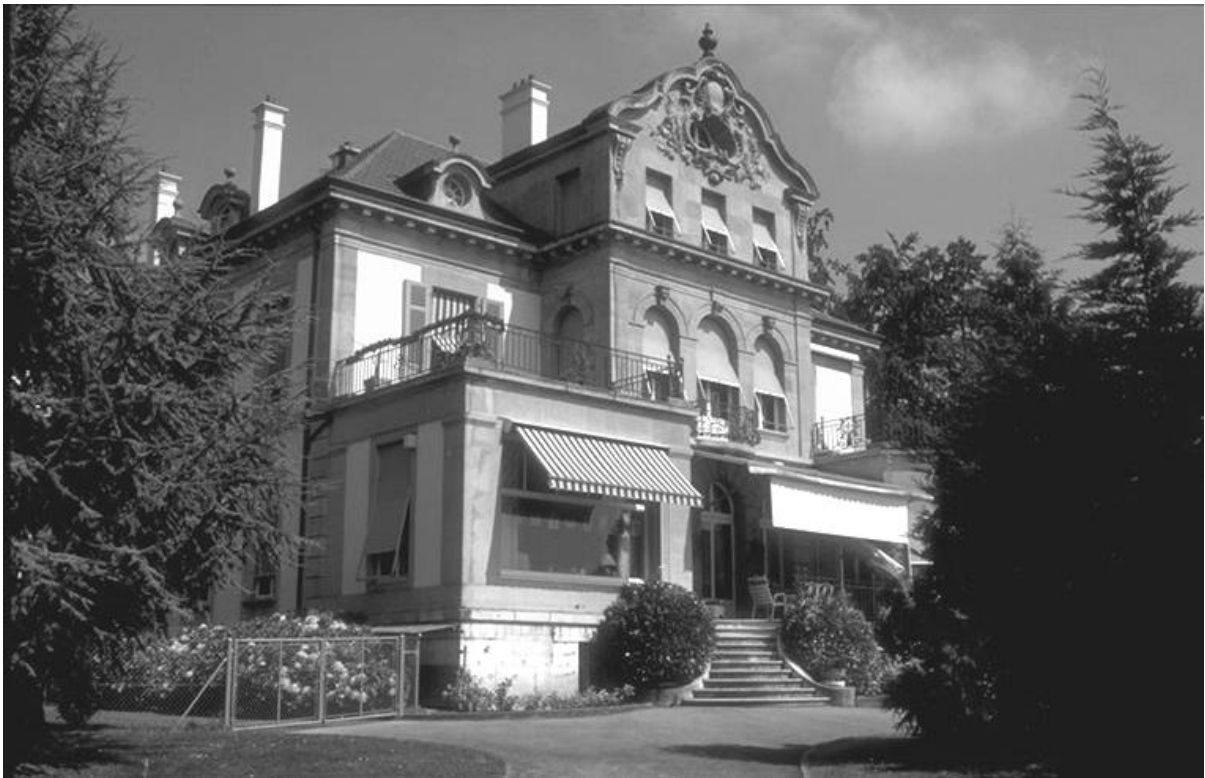
Figure 3. Vue de la façade de la maison de maître
