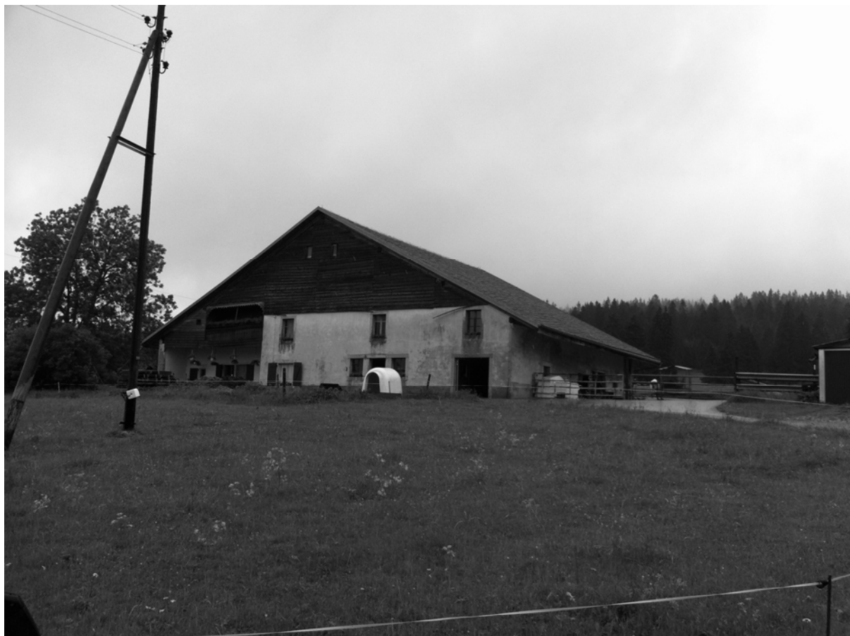
Élévation nord de la Rotte 1 avant incendie
