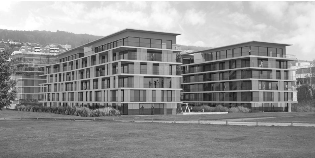
Vue des deux bâtiments d'habitation projetés depuis les grèves du lac
