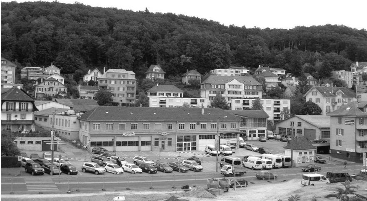
Figure 1 Vue de la place encombrée de véhicules stationnés, avant la démolition des bâtiments.
