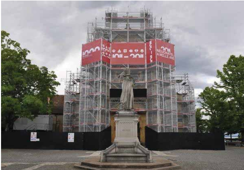
Figure 12. Bâches du Millénaire. Source : http://vinsconfederes.ch
