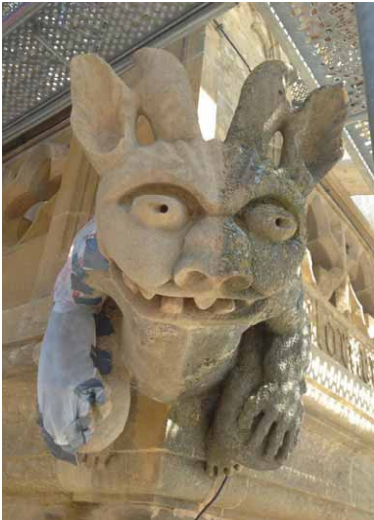
Figure 3. Nettoyage et consolidation d'une gargouille
