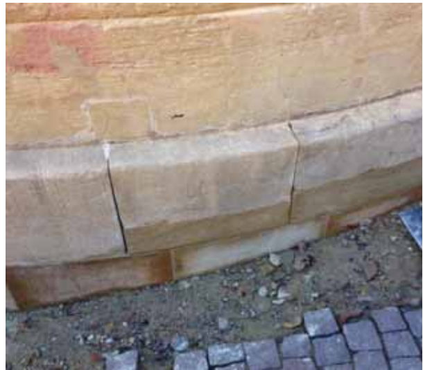
Figure 5. Changement de pierre en pied de façade Est
