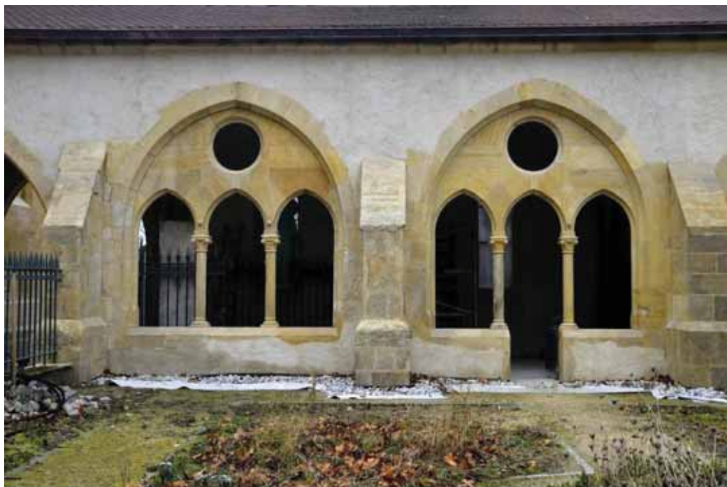
Figure 11. Façade intérieure après réfection du crépi et nettoyage de la pierre
