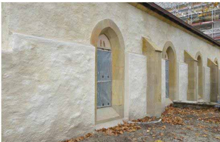
Figure 10. Façade Ouest. Réfection du crépi et nettoyage de la pierre
