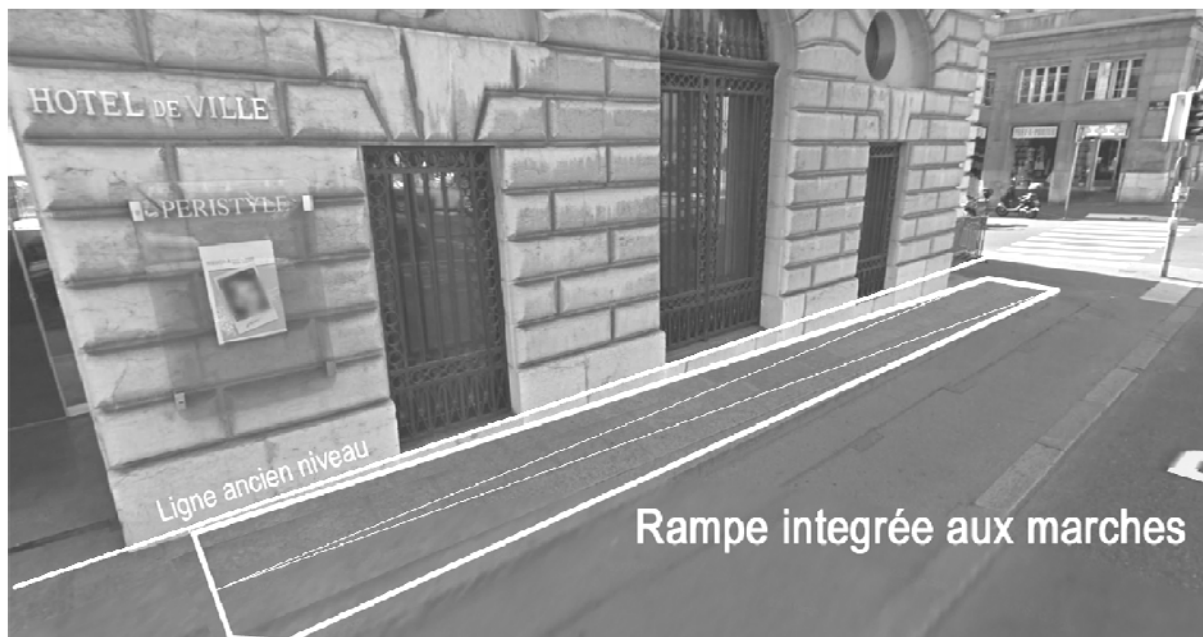
Figure 10. Nouvel accès Est
