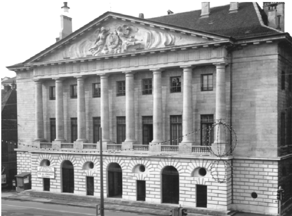
Figure 4. Façade après travaux. Situation que nous devrions retrouver avec le crédit sollicité
