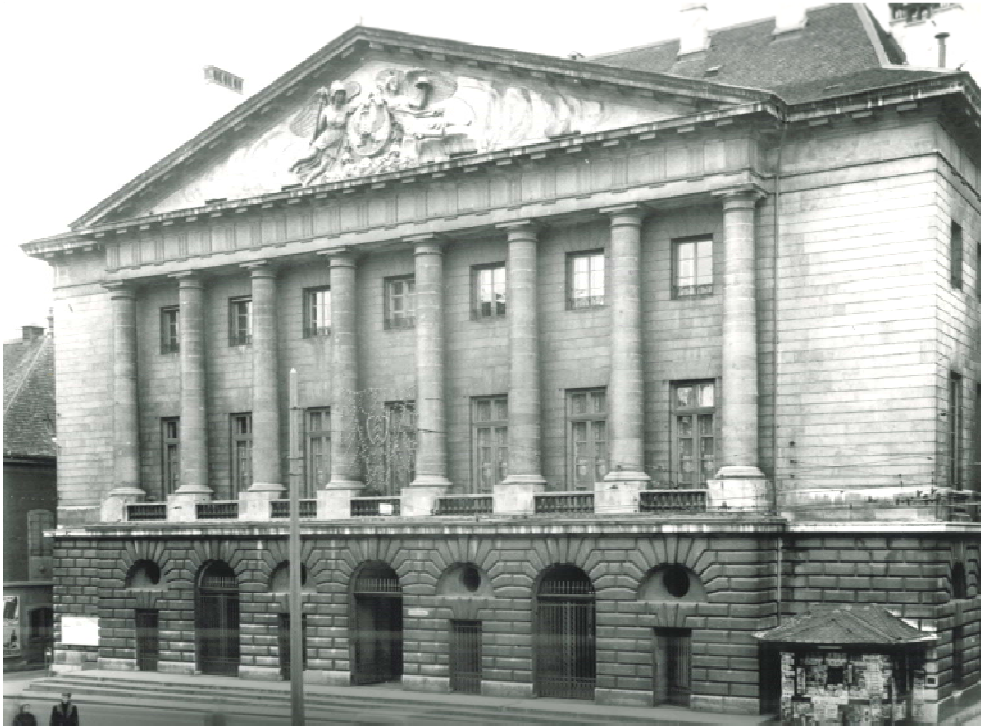
Figure 3. Façade avant travaux
