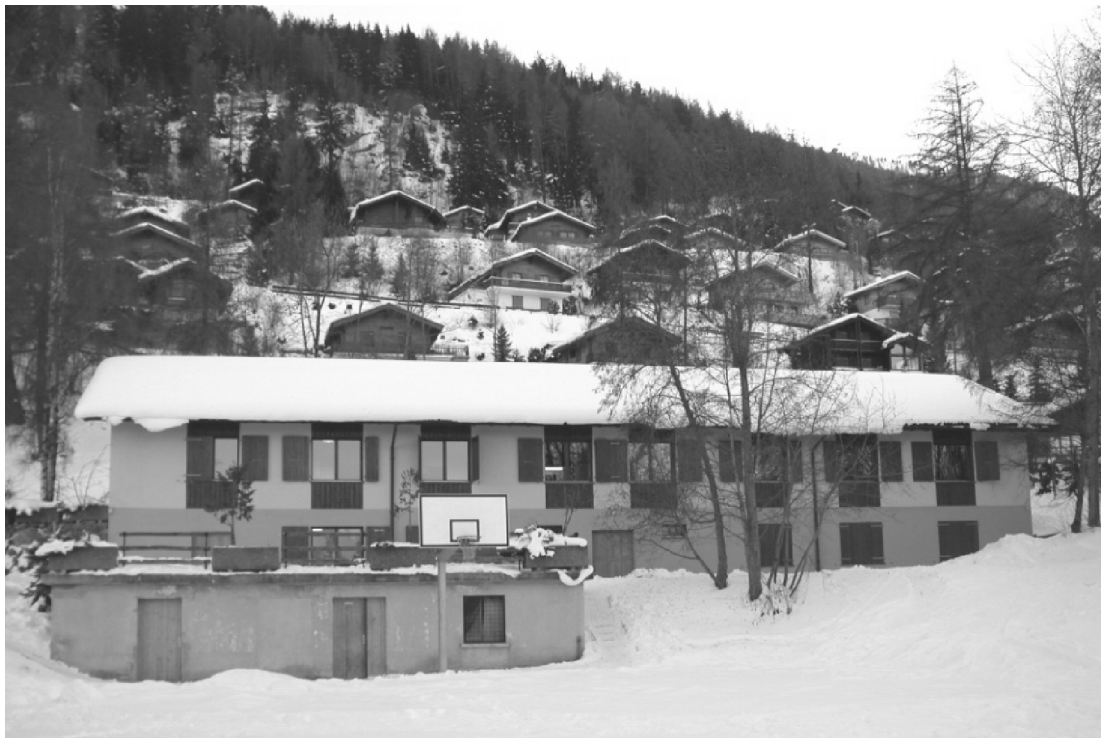
Vue du pavillon aménagé en dortoirs
