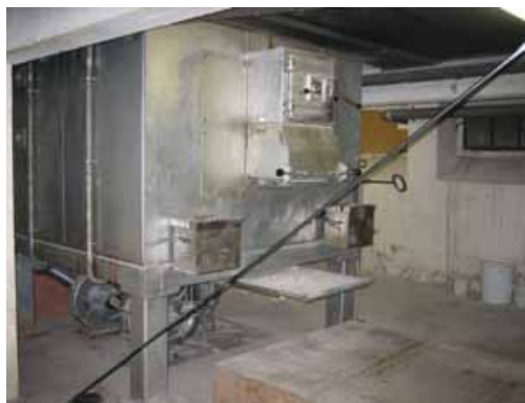
Fig.4 : Sous-sol de la salle des fours
