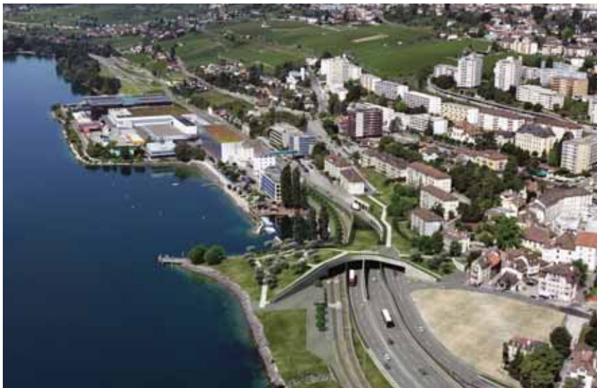
Figure 1 : un accès direct et aisé au lac retrouvé depuis le bas de Serrières, tranchée couverte
