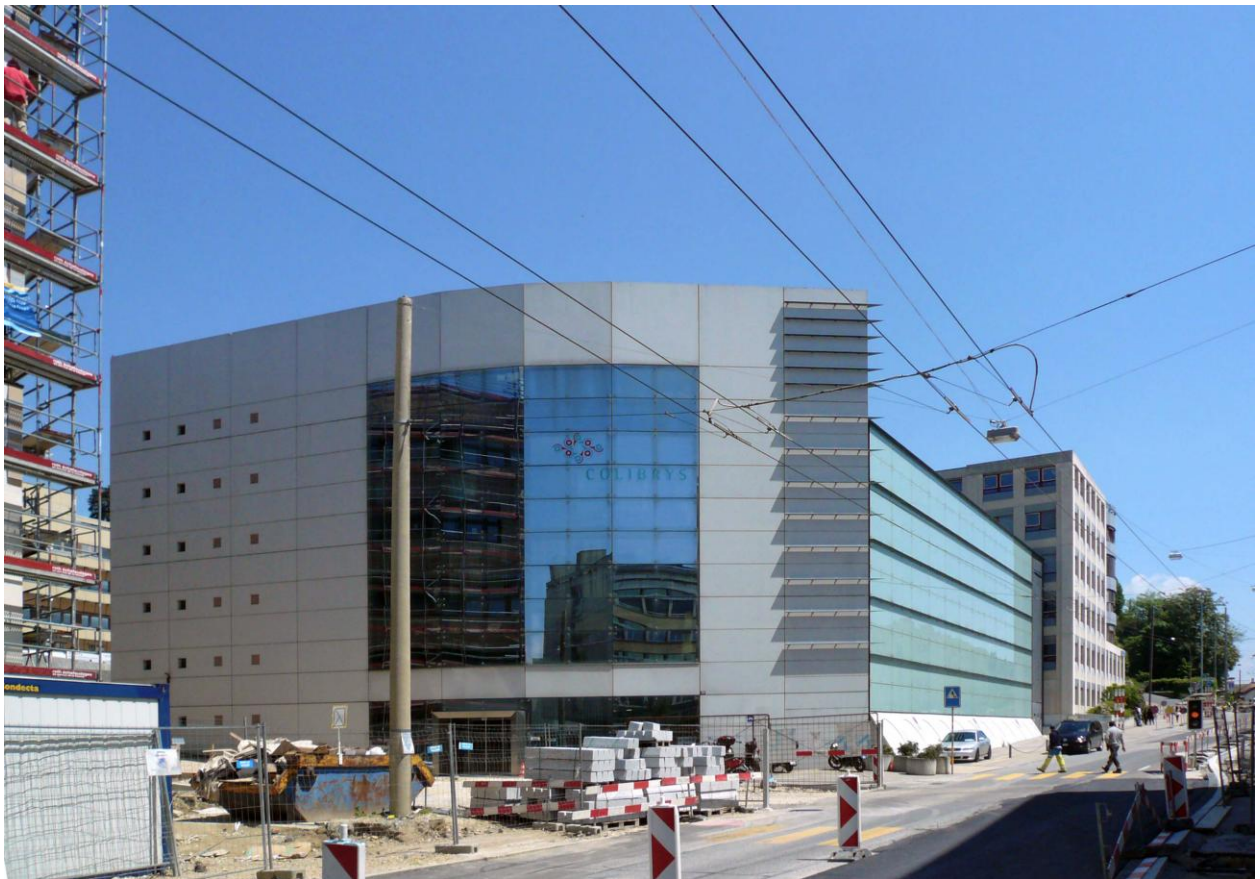
Façade existante du bâtiment (photo prise pendant le chantier Microcity)
