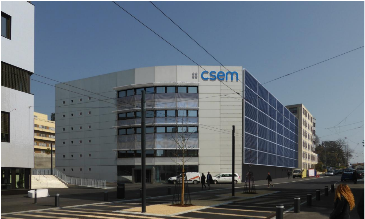
Façade avec écran photovoltaïque (GD architectes FAS SA)
