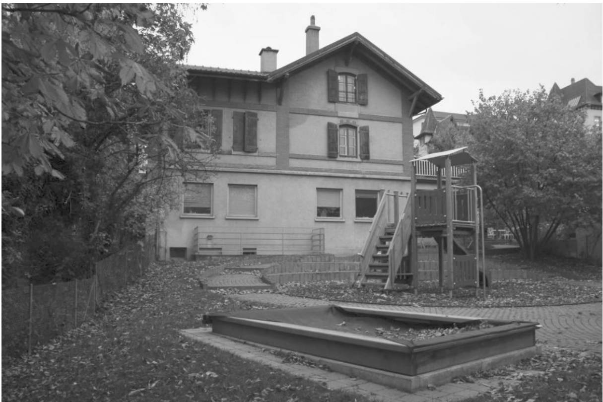
Figure 2 : Vue de la façade sud du bâtiment et du parc, état existant.
