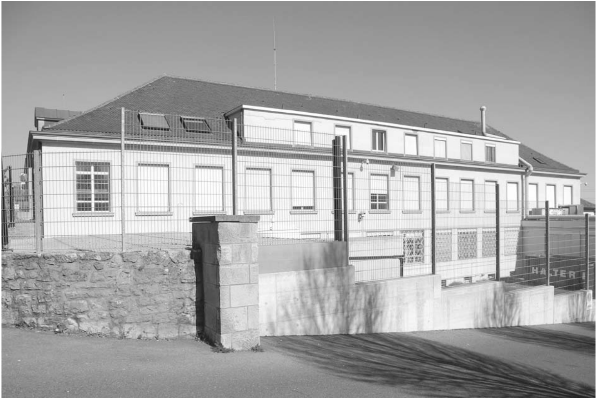
Vues de l'ancien bâtiment administratif de l'usine Metalor : en haut, façade sud-ouest ; en bas, façade côté rue du Vignoble
