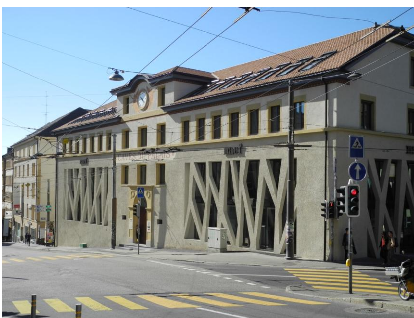
La façade rénovée des Caves du Palais
