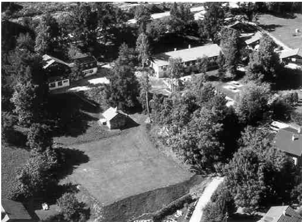
Vue d'ensemble de la propriété « Cité-Joie »
