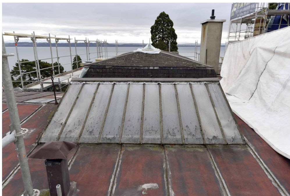
Figure 19 : Toiture de la Villa de Pury
