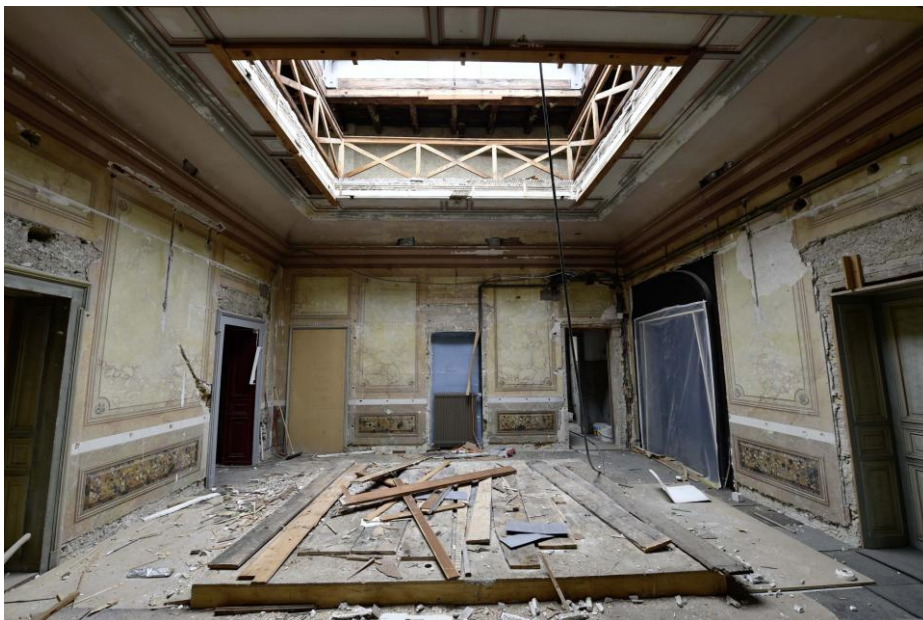
Figure 10. Image prise après le démontage de l'exposition Retour d'Angola au 1 er étage de la Villa de Pury. On peut y voir le puits de lumière à nouveau ouvert.
