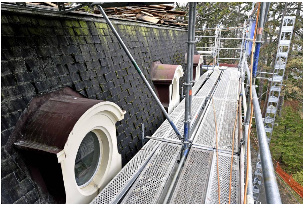
Figure 18 : Détail des lucarnes de la façade nord de la Villa de Pury
