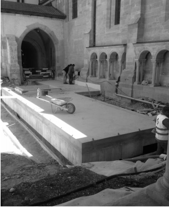
Figure 1. Local de chauffage
