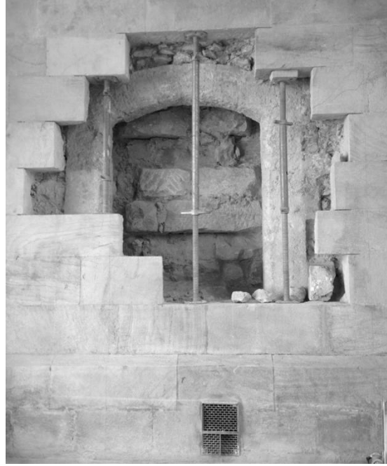
Figure 2. Porte de liaison en ouest
