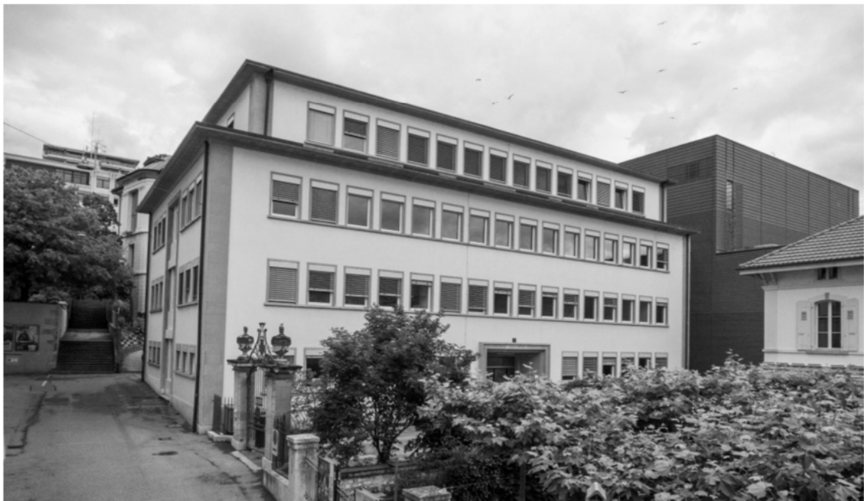
Figure 1 : Bâtiment passage Maximilien-de Meuron.
