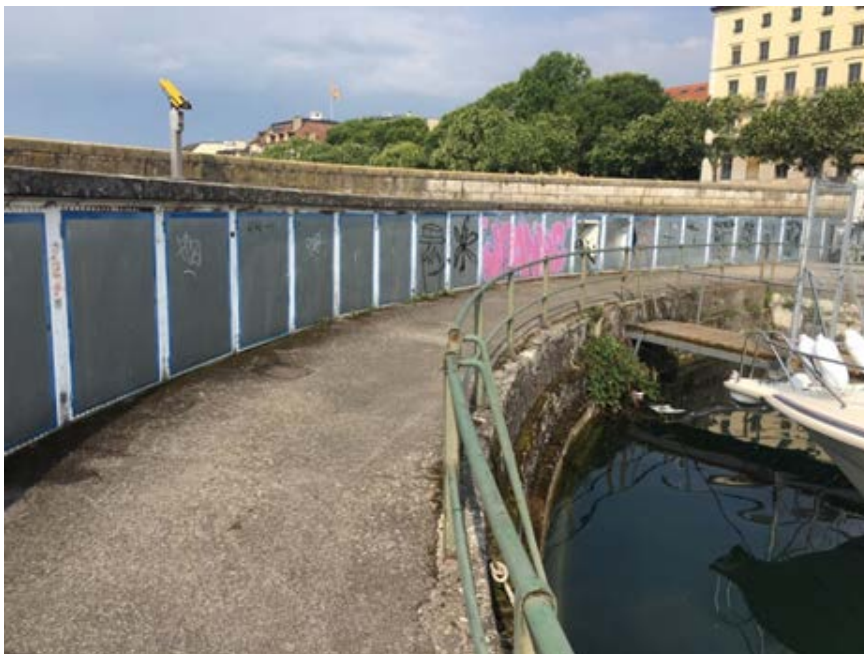
Anciennes vitrines du port de Neuchâtel remplacées par des tôles actuellement
